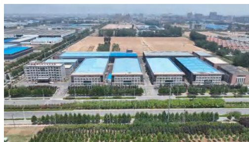
图 3 沁南园区航拍图
