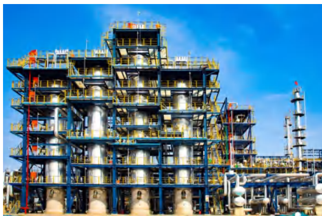
图1 15万吨/年可持续航空燃料项目装置
