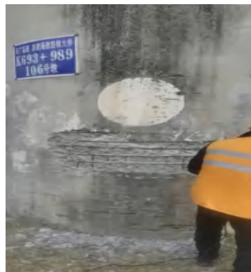
图3 国铁桥墩维修施工
