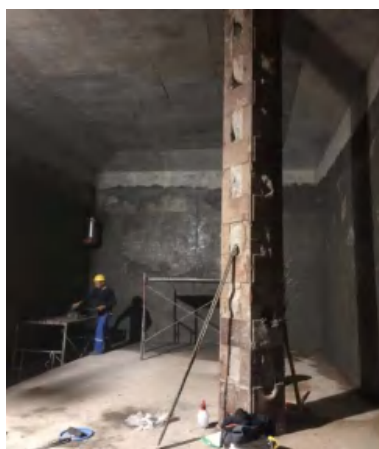
图 4 郑州地铁站台蓄水池施工
