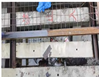
图 1 高铁护栏防腐处理
